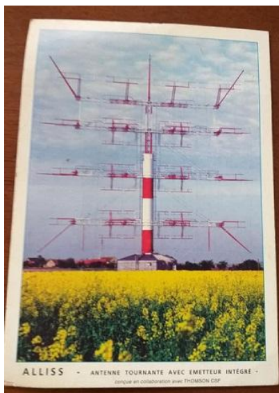
写真015,016: ラジオフランスインターナショナル (RFI) アンテナの有名な写真で、短波送信と他の送信サービスを送信するために、それぞれ500kWの12個の送信機から電力を供給される12個の回転ALLISSアンテナです。
